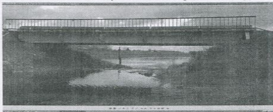
Фото 1.1 Общий вид искусственного дорожного сооружения
